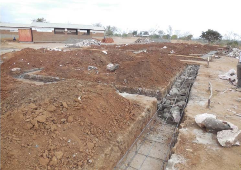
A mano a mano che gli scavi delle fondazioni vengono completati segue il riempimento con le pietre , il ferro e il cemento
