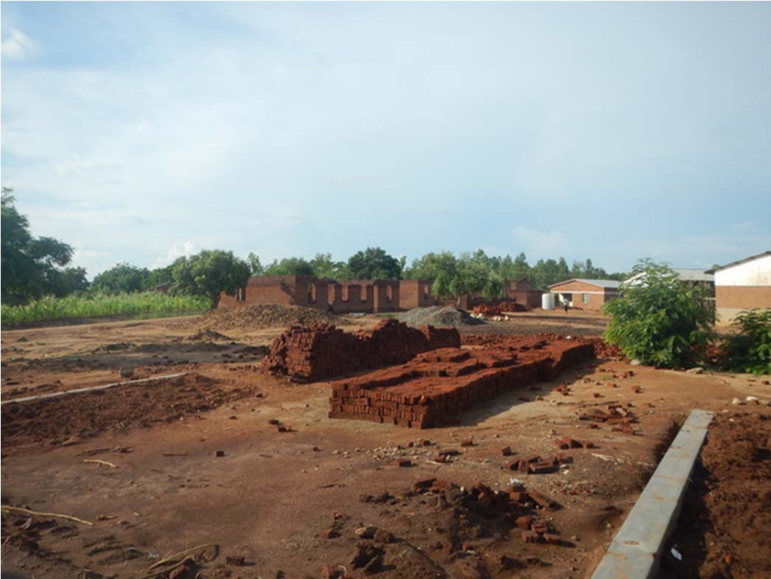
i muretti di contenimento che serviranno a contenere l'erosione che si stava portando via la scuola...
